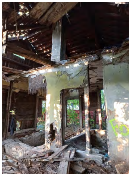
Wnętrze stacji Częstochowa Warta
